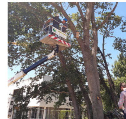
Installation des nichoirs sur le site
